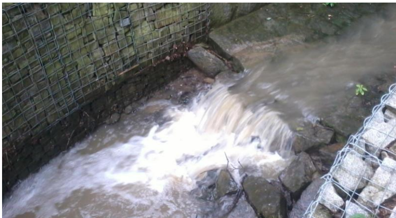
Foto č. 9: SO 02 - Úsek 1 – pohled po směru toku. Splávní na pravém břehu bude odstraněno, část větví v korytě seříznuta.
