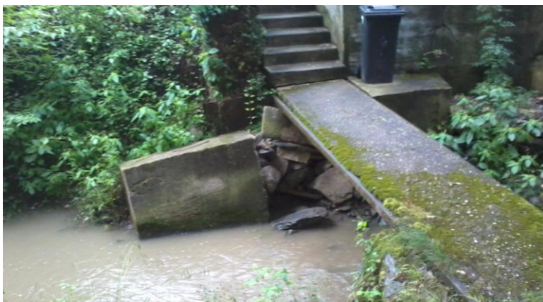
Foto č. 7: SO 01 - Úsek 7 – pohled proti směru toku na opevněnou část koryta pod Mlýnským rybníkem. Gabion místy doléhá na skalní podloží, místy je podemletý. Pod gabionovou konstrukci budou uloženy kameny, ve dně bude do výmolů doplněn lomový kámen.
