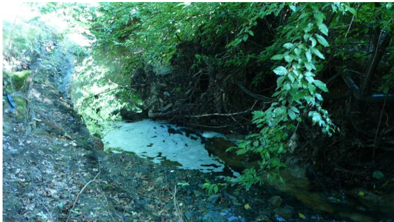
Foto č. 10: SO 02 - Úsek 2 – pohled proti směru toku. V levém břehu je patrný výmol, na pravém břehu pak náplav štěrku.
