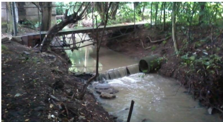
Foto č. 5: SO 01 - Úsek 5 – pohled proti směru toku. Koryto je zde zúžené, levý břeh je v patě vymletý. Výmol bude opatřen lomovým kamenem, nánosy z pravého břehu budou odtěženy.
