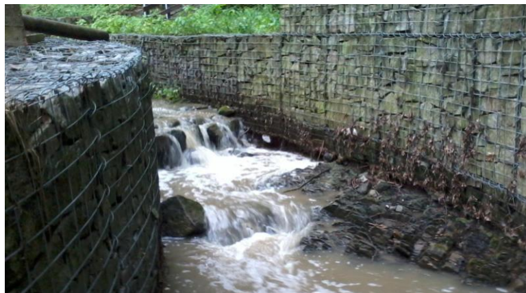
Foto č. 7: SO 01 - Úsek 7 – pohled proti směru toku na opevněnou část koryta pod Mlýnským rybníkem. Gabion místy doléhá na skalní podloží, místy je podemletý. Pod gabionovou konstrukci budou uloženy kameny, ve dně bude do výmolů doplněn lomový kámen.
